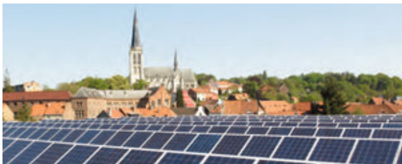
Eind 2007 kreeg de nieuwe Colruyt-vestiging in Alsemberg 420 m 2 zonnepanelen op het dak.
